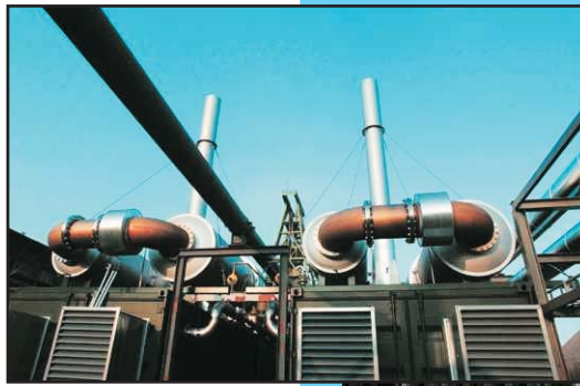
Bergwerk Lohberg - BHKW-Module, Quelle: Mingas-Power GmbH
