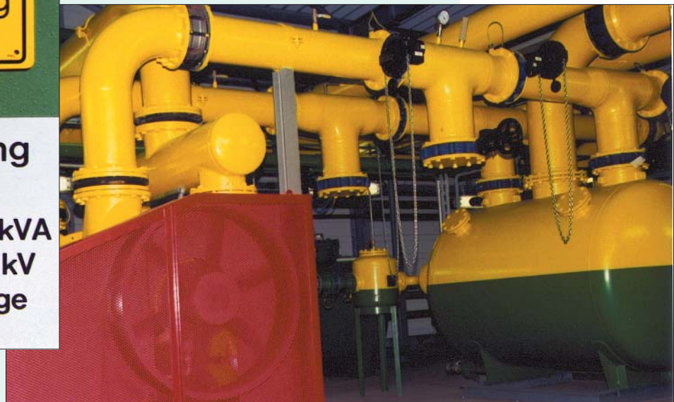
Gasabsaugestation Bergwerk Ost: 120 kW-Wasserringpumpen mit Abscheidebehälter und Sammelwasserbehälter
