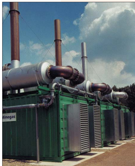
Kurl 3, BHKW-Container 3 x 1.350 kW el -Leistung
