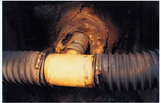
Anschluss Gasbohrloch
