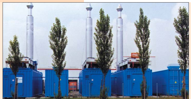
Grubengasbetriebene (3 x 1,35 MW el ) BHKW-Module am ehemaligen Schacht Minister Achenbach 2, Lünen, der Firmengruppe "A-TEC/pro2"
