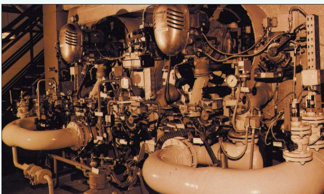
Verbundbrenneranlage, Kessel EVA
