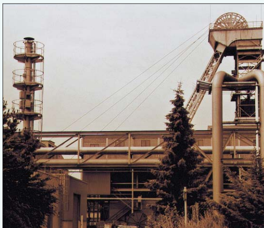
Schacht von Oeynhaus 3 mit Grubengasausblaseeinrichtung (links)
