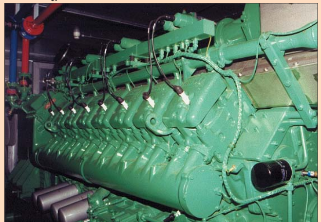
1.350 kW el -BHKW-Modul
