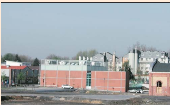
EnD-I Grubengaskraftwerk auf dem ehemaligen Bergwerk Lothringen in Bochum-Gerthe
