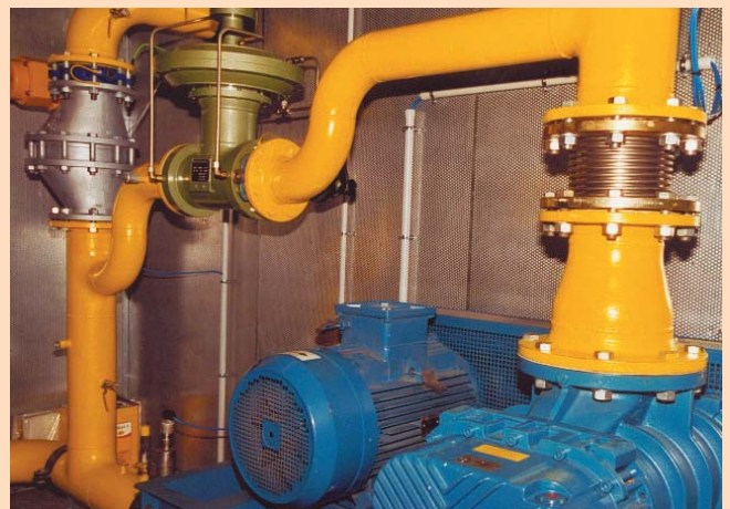
Grubengasverdichterstation
