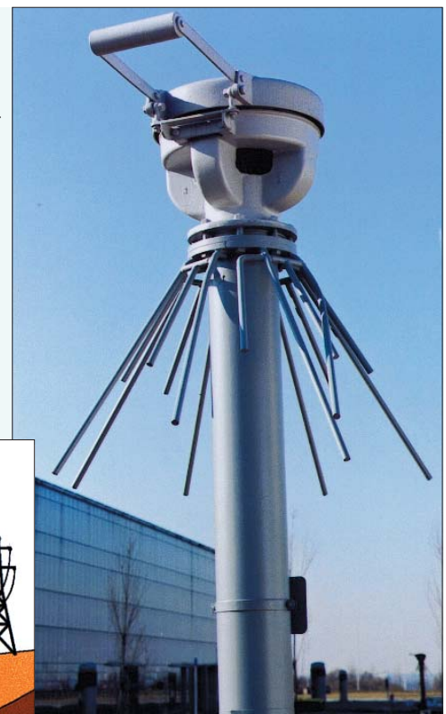
Protegohaube auf dem Schacht Mont Cenis
