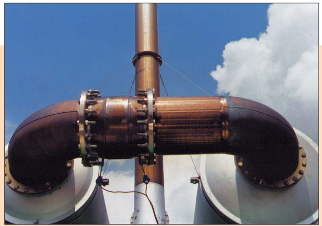
Schalldämpfer mit Katalysator, Abgasführung und Abgaskamin eines BHKW
