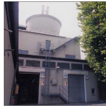
Grubengas-Heizkraftwerk der Stadtwerke Dinslaken GmbH auf dem Gelände des Bergwerks Lohberg
