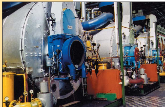
Bergwerk Ost: Dampfturbine, oberes Foto v.l.n.r.: Generator, Getriebe, Turbine und Maschinenzentrale mit 3 Dampfkesseln (Foto Mitte)
