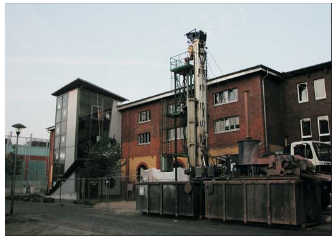
Grubengasbohrung auf dem Schacht Lothringen 6
